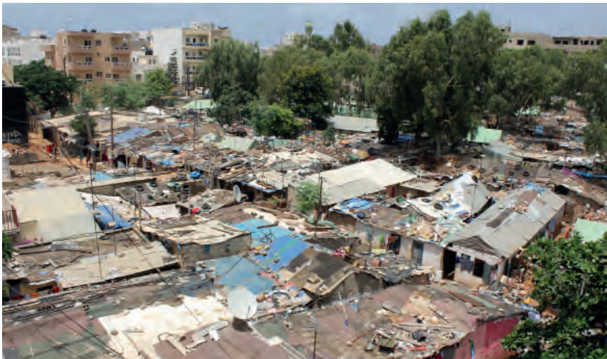
Die alten Slumhütten – vor dem Bau der neuen Wohnungen
